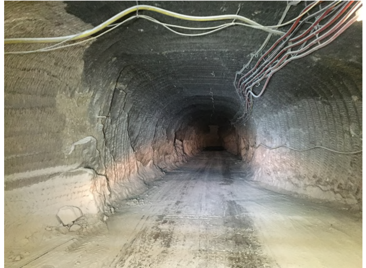
Quelle: BGE Asse II – 725-m-Sohle
